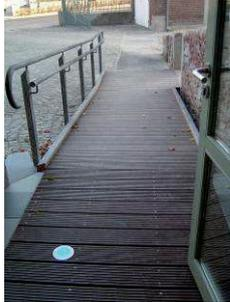
*Pour compenser une marche de 5 cm, un plan incliné en pente douce mesure minimum 20 cm de long ; pour une marche de 9 cm, il mesure minimum 30 cm ; pour une marche de 16 cm, il mesure minimum 2 m ; pour deux marches de 35 cm (total des 2 hauteurs), il mesure minimum 5 m.*
