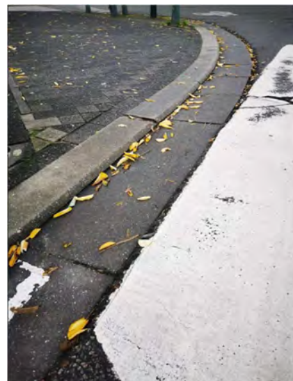
Traversée piétonne N°48
