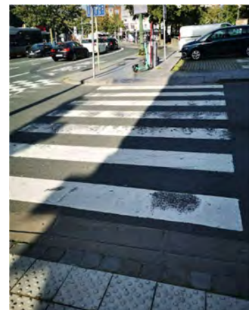
Traversée piétonne N°25
