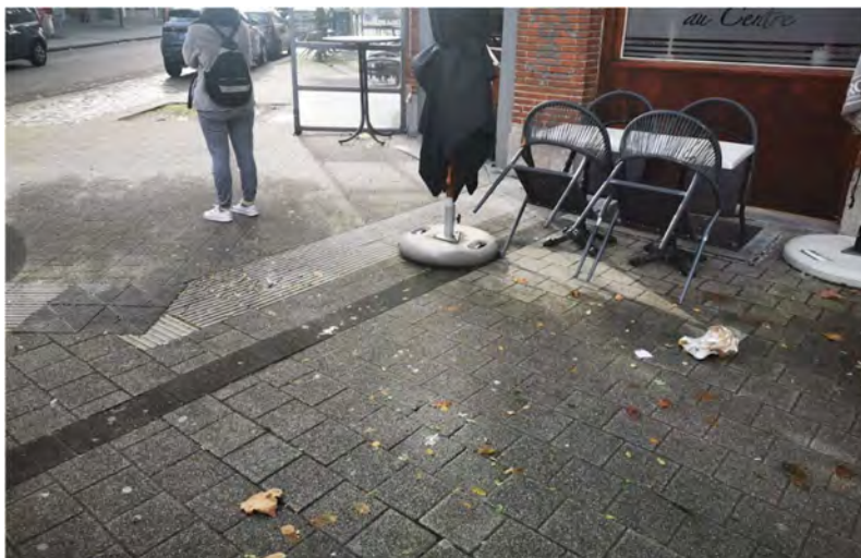
Traversée piétonne N°23
