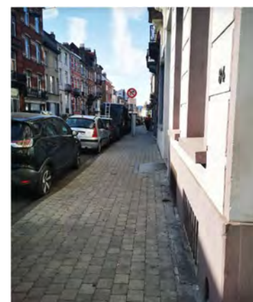
Trottoir – section W
