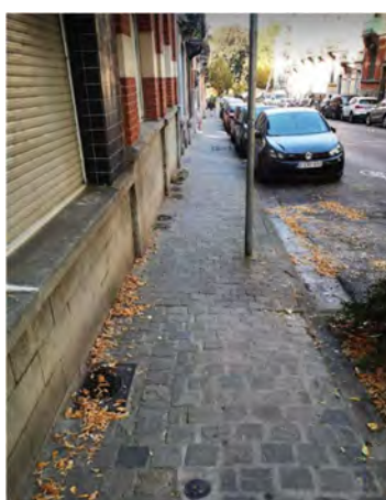
Trottoir – Gd rue Haut Bois (section B)
