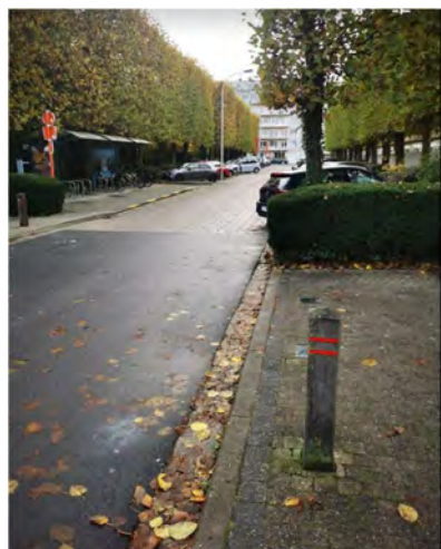
Trottoir - Section K2 bis
