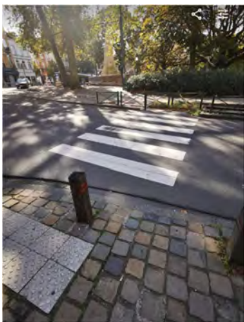
Traversée piétonne N°6 bis
