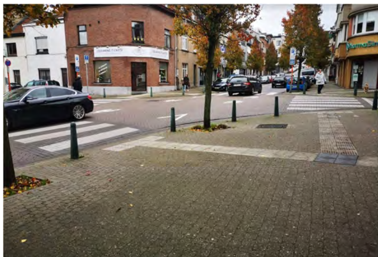
Traversée piétonne N° 31-34
