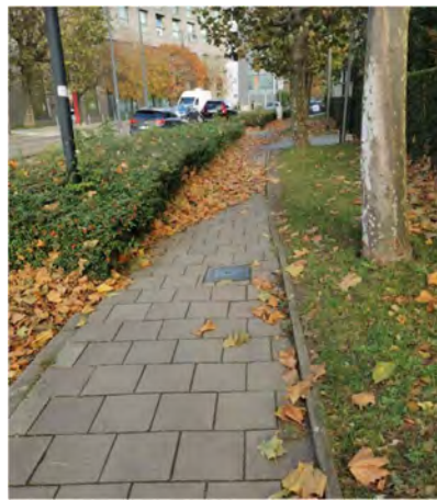
Trottoir - section W
