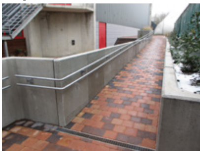
Rampe à l'entrée
